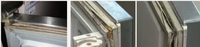
汚れ固着・黒カビ発生
